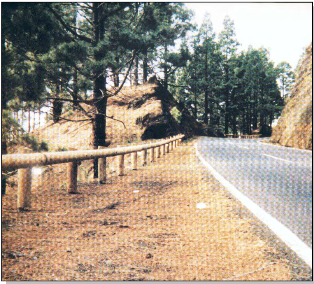
FIGURA 6.502.10.A EJEMPLO DE BARRERAS MIXTAS
